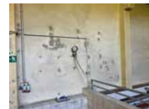
Fotos links Maschinenhalle vorher
