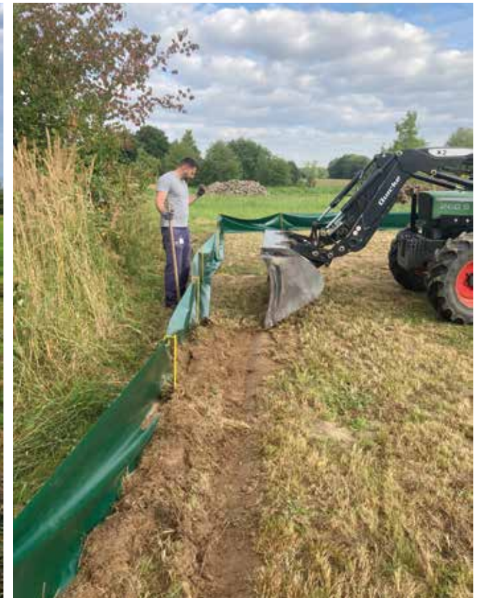
Foto unten links Zauneidechse wird von der Bearbeitungsfläche umgesetzt Foto unten rechts Fläche nachdem Stümpfe gerodet wurden
