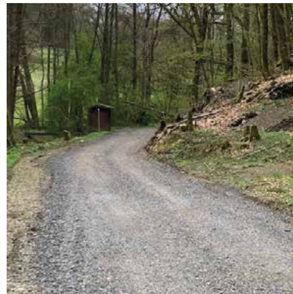
Foto Ertüchtigter Weg zur Messstelle Wendbachtal
