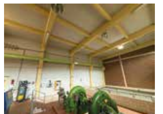
Fotos rechts Maschinenhalle nachher
