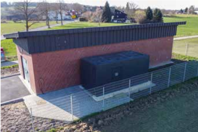
Foto Pumpwerk Sückterscheid Netzersatzanlage
