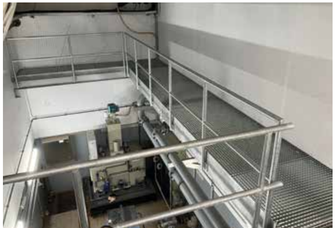
Foto Gitterrostbühne SN4 nach Fertigstellung
