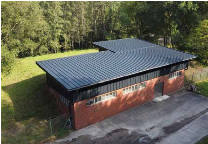
Fotos Dach des Betriebsgebäudes Ohmbach vor und nach der Dacherneuerung
