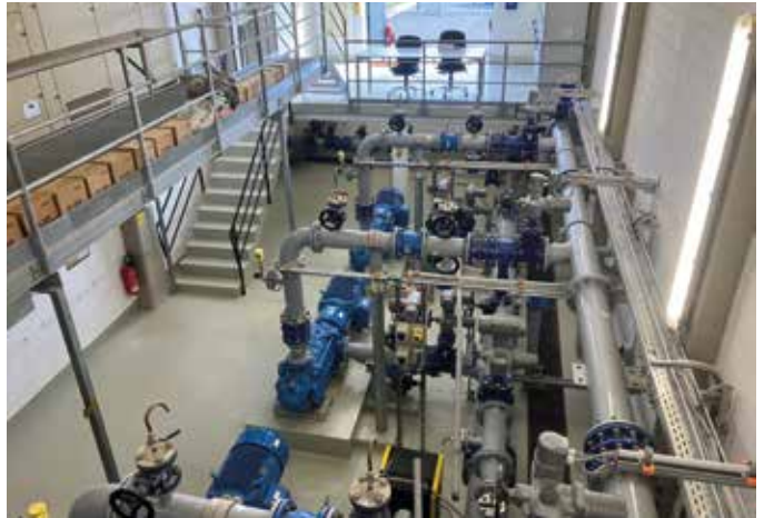
Foto Betriebsanlage Süchterscheid nach der Bodenerneuerung
