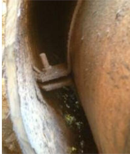
*Unter der Mittelinsel der Bonner Straße wurden in enger Abstimmung mit der Stadt Meckenheim die Stahlrohrleitung erneuert sowie Stahlkufen entfernt und durch Betonfundamente ersetzt.*
