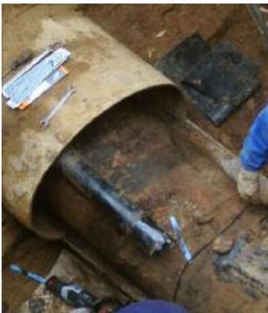
der auch eine messtechnische Überwachung des Korrosionsschadens ermöglicht. Nach intensiven Messungen wurden Kurzschlüsse zwischen dem im Kreisbereich verlegten Stahlrohr DN 600 und dem Produktrrohr DN 600 (durch die die beiden Rohrleitungen verbindenden Stahlkufen verursacht) festgestellt.
