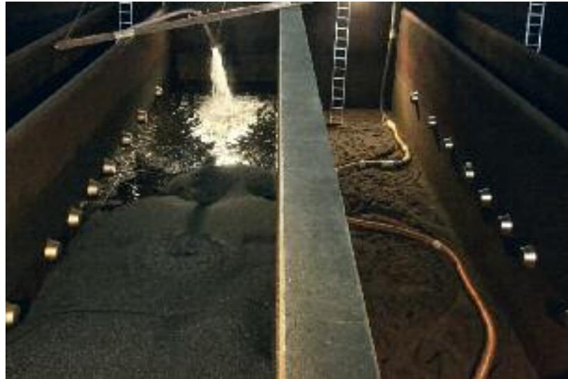
*Während im linken Becken schon Filtermaterial eingefüllt wurde, musste im rechten Becken noch Quarzsand abgesaugt werden.*
