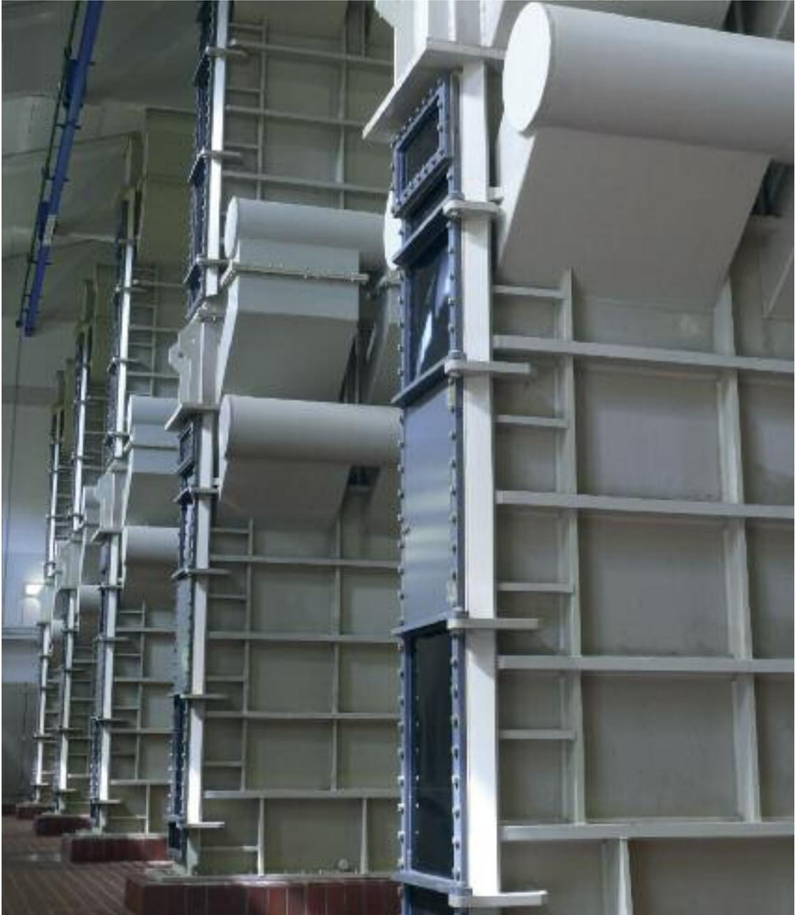
*Auf dem Betriebsgelände am PW Selgenthal erfolgt die physikalische Entsäuerung mittels Wellbahnrieslern.*
