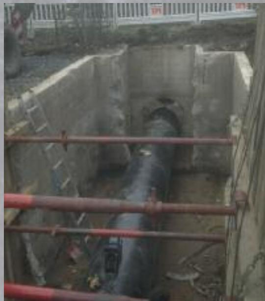
wurde auf einer Länge von 16 m eine neue Rohrleitung, DN 700 mit Kunststoffgleitkufen versehen, eingezogen und im Bereich des zurückgebauten Schachtbauwerkes eine Leitung DN 800 verlegt sowie mit Beton ummantelt.
